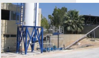
Обработка известью с помощью установки Gavo™ на предприятии по очистке сточных вод
