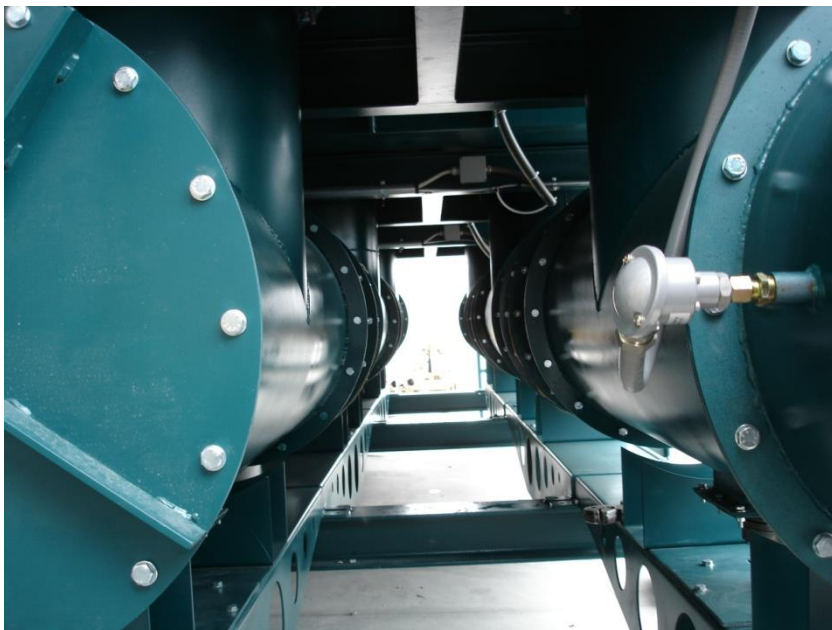
Клапаны без изоляции
